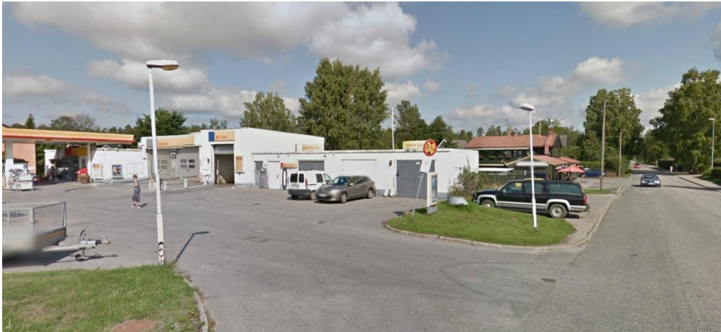
Vy mot planområdet och Kärrvägen, sett från söder.
