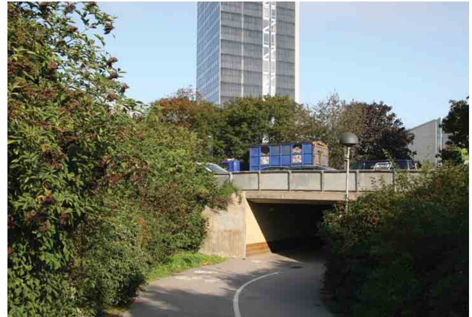
Viadukten vid Sveaplan omges av tät buskage.
