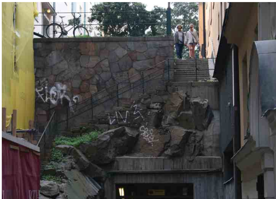
Vy från trappanläggningens nedre del.
