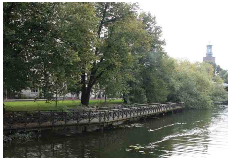
Gångbron byggdes på 1940-talet.
