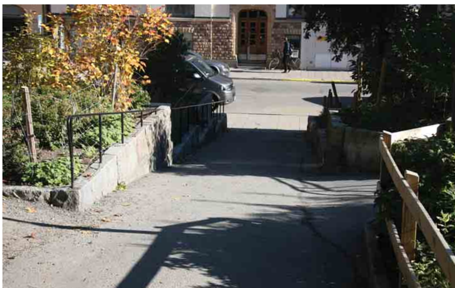
Brant ramp mot Hälsningegatan med handledare integrerad i stödmuren.
