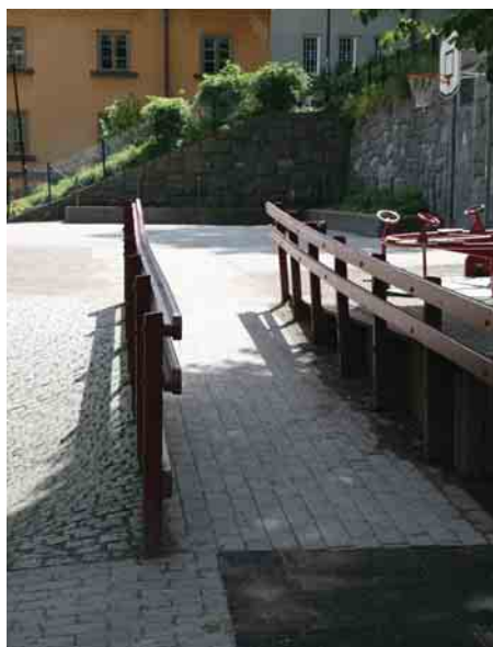
Rampen mellan parklekens två nivåer.
