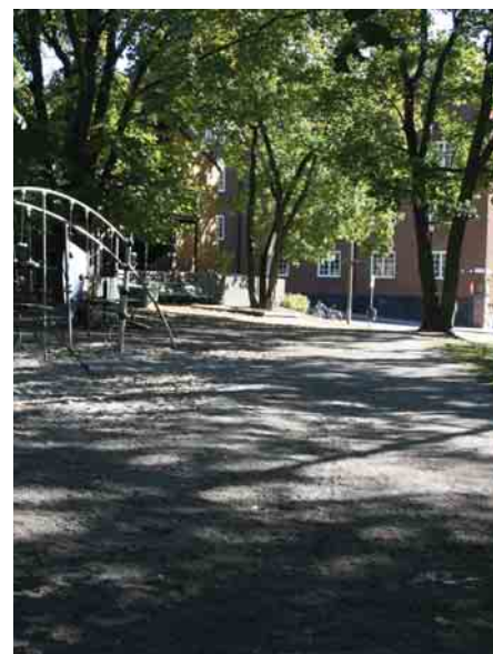
Stensmjöl har runnit ut över den asfalterade gångvägen som nu är svår att se.
