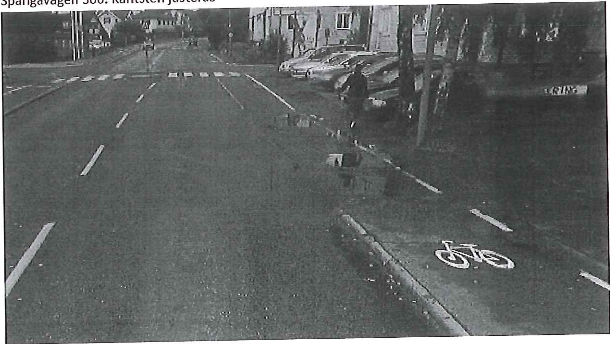
Spångavägen 306. Kantsten justeras
