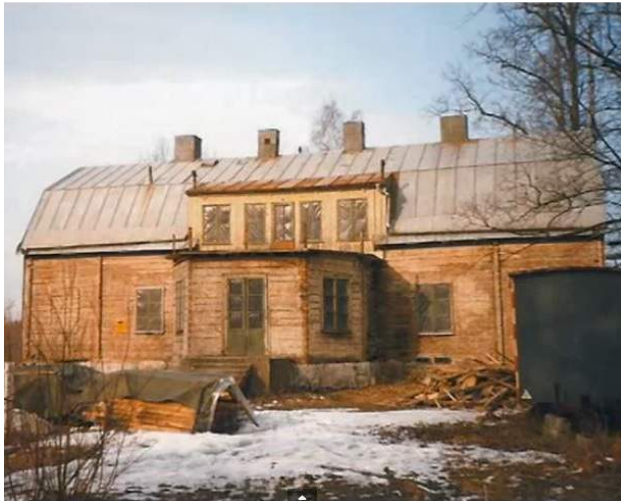
Renovering påbörjad 1984; träpanelen har tagits bort. Den på 1930-talet tillkomna frontespisen är ännu kvar. Foton ur Sellergren 2012.
