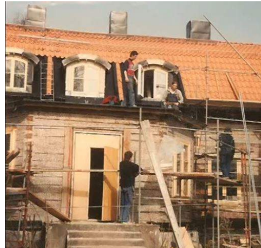
Under renoveringen. Frontespisen har ersatts av takkupor anpassade till byggnadens karaktär och ålder.
