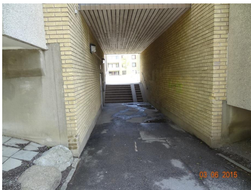
Passage från Axbyplan. Hög och brant ramp, det går inte att passera med rullstol.
