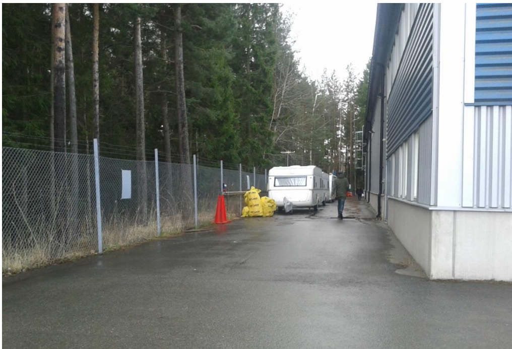
Bilden visar den västra sidan av fastigheten Lastbilen 7, sett från norr. Till vänster syns den skogsmark som i planförslaget tas i anspråk för utbyggnad av icke störande industriverksamhet.
