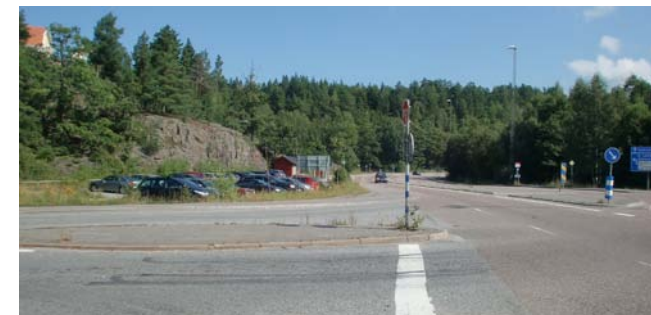
Korsningen Värmdövägen-Gamla Skärgårdsvägen byggs om till cirkulationsplats
