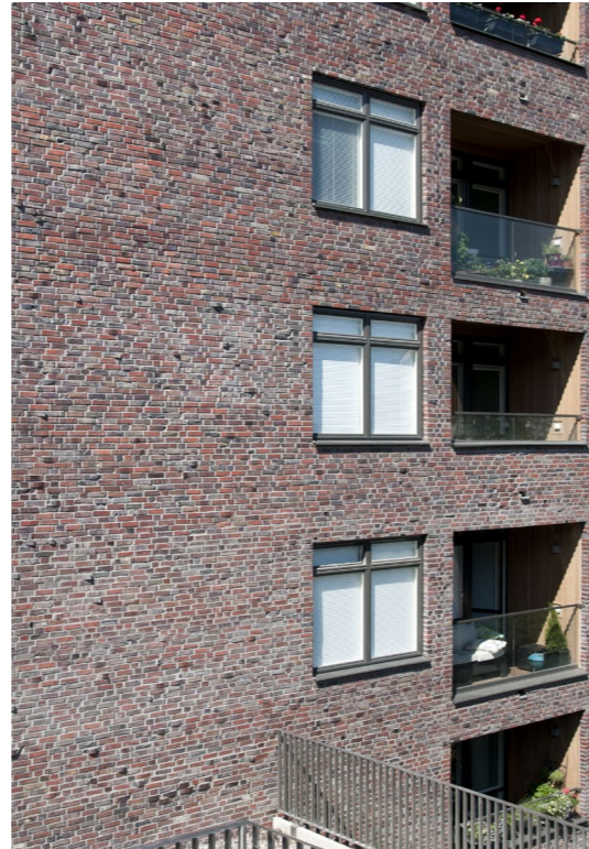
8. Tegelräcken vid indragna balkonger Rackarbergen, Joliark
