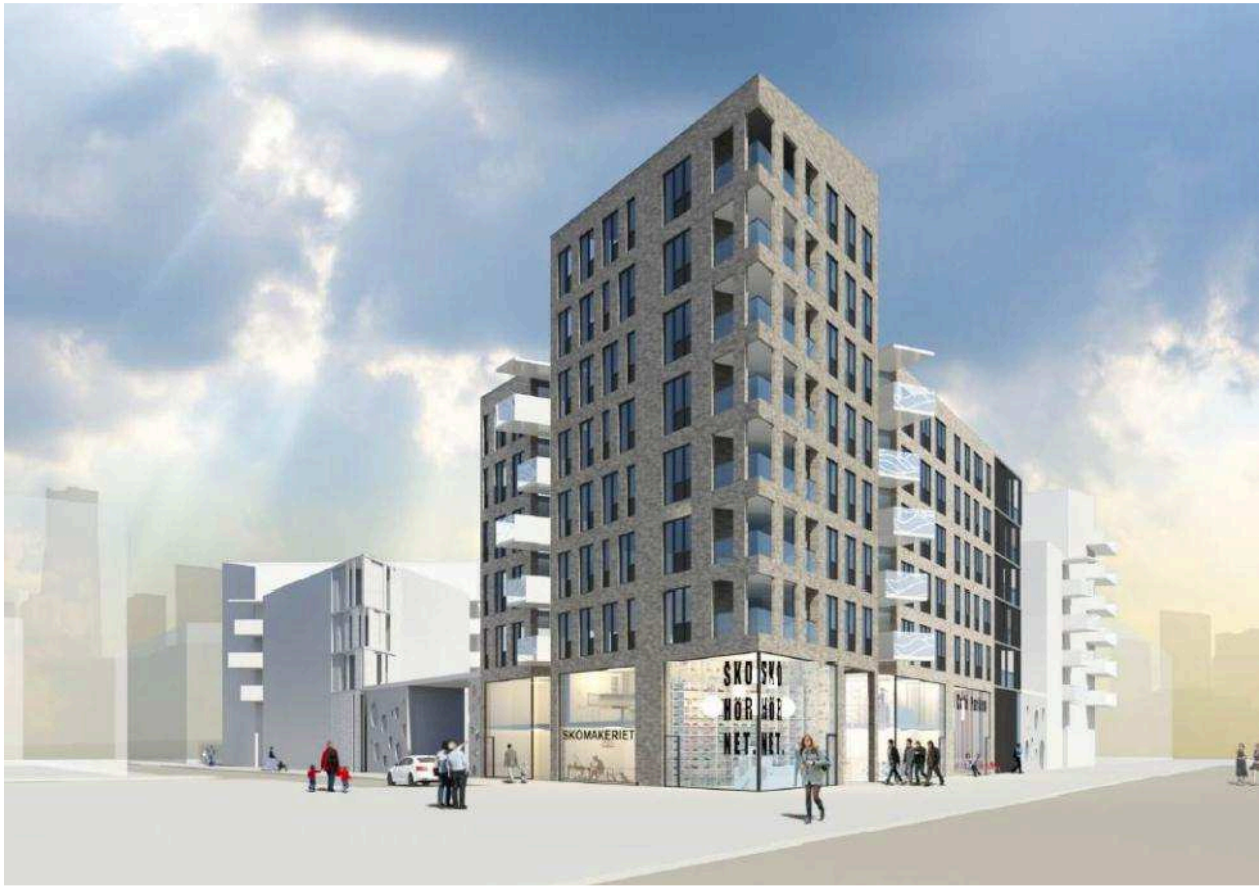
Kvarteret sett söderifrån från parken. Tornen fyller ut kvarters triangulära form. Illustration AQ arkitekter.
