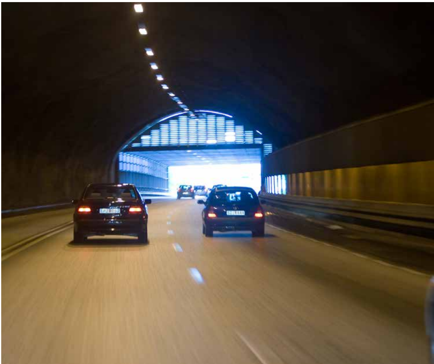
Krav på god boendemiljö och konkurrens om utrymmet tvingar ner trafiken i underjorden. Det är särskilt viktigt att trafiken i tunnlar rullar.
