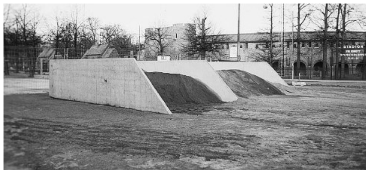
Exempel på ett s k planlager
