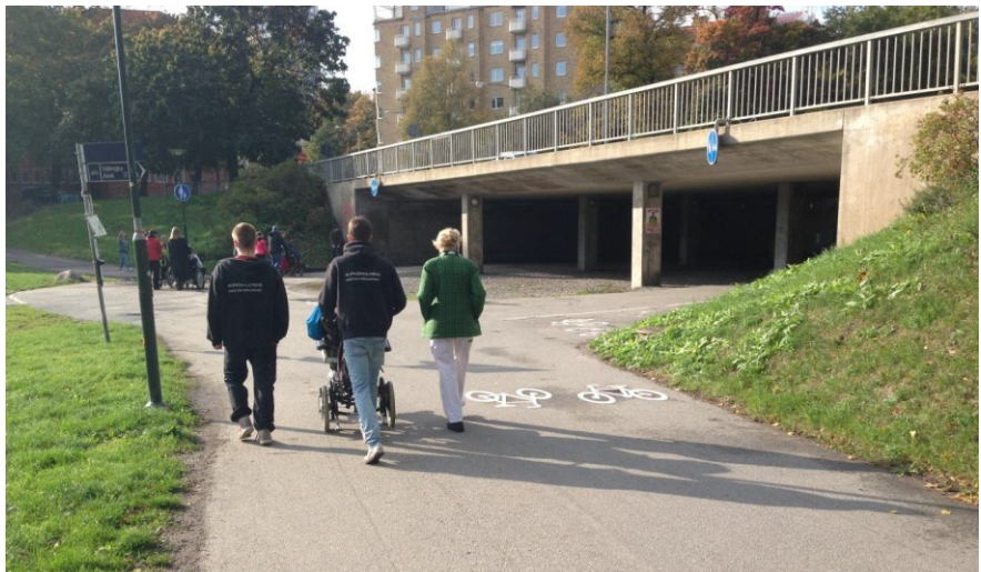
Figur 2. Delade gång- och cykelbanor i parken vid tunneln under Gjörwellsgatan
