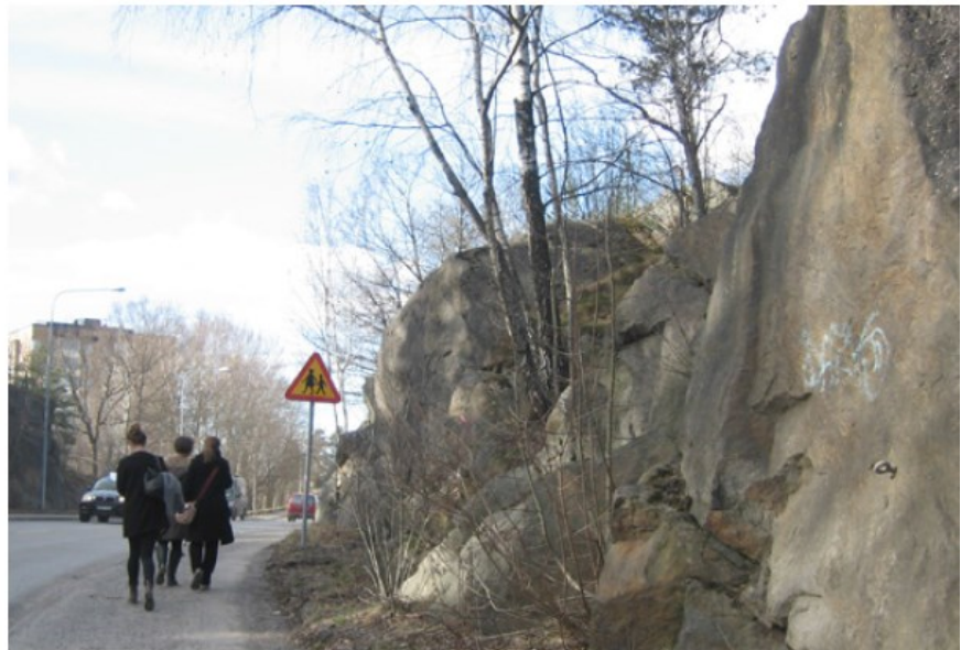
Bild 2. Berget utmed Magelungsvägen, som platsen ser ut idag.
