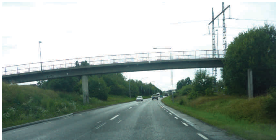
Bergslagsvägen, Spånga: Både väggar och golv är transportrum. Bebyggelse saknas i anslutning till vägen. Oskyddade trafikanter korsningsbehov sker planskilt.
