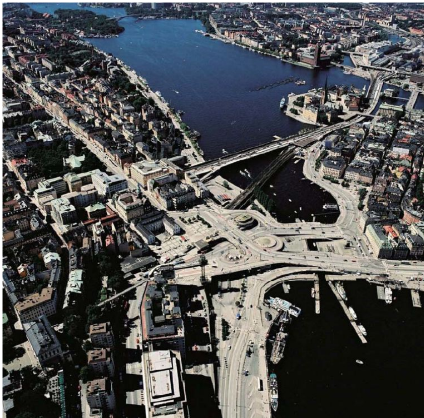
Figur 1: Den befintliga Slussen
