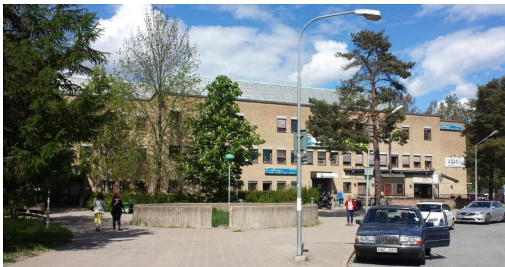
Befintlig byggnad inom fastigheten Forellen 2 sett från söder. Huset innehåller bland annat vårdcentral, folkandvård och en restaurang.
