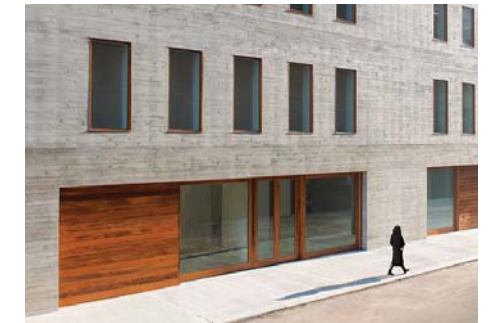
STORA HÅLTAGNINGAR I STENSOCKEL
