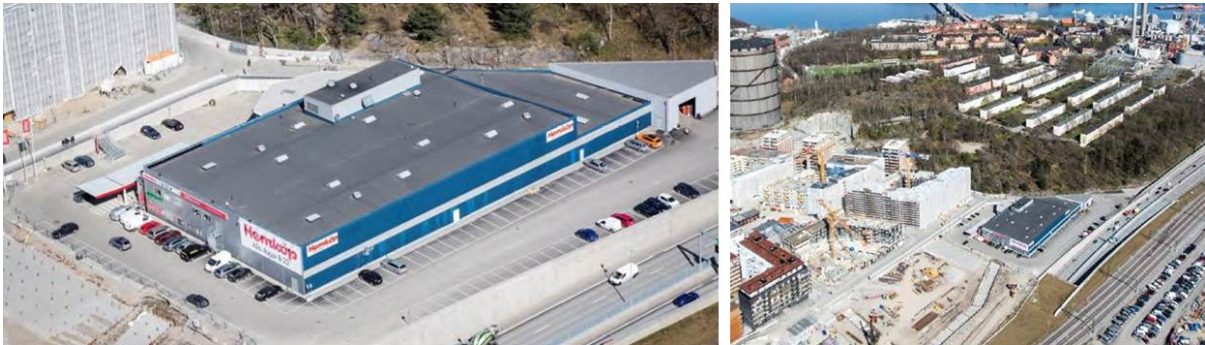
Bild: Ängsbotten 8 i Norra Djurgårdstaden
