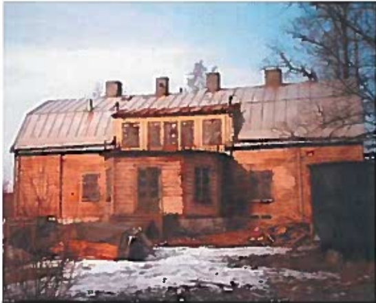
Renovering påbörjad 1984; träpanelen har tagits bort. Den på 1930-talet tillkomna frontespisen är ännu kvar. Foton ur Sellergren 2012.
