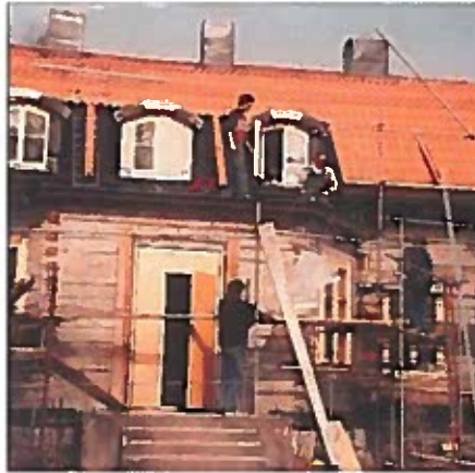
Under renoveringen. Frontespisen har ersatts av takkupor anpassade till byggnadens karaktär och ålder.
