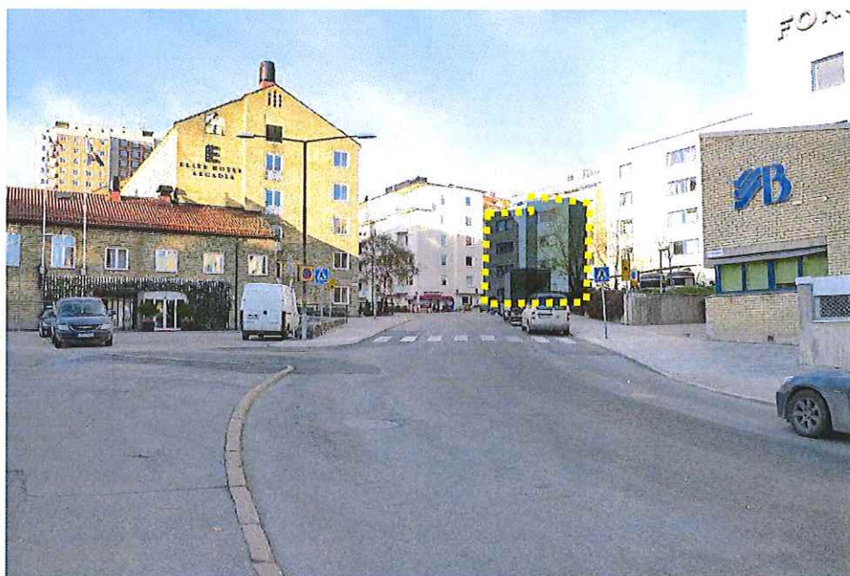
Fotomontage synlighet från Valhallavägen. Huset döljs bakom befintliga hus. Dold kontur redovisad som gulstreckad markering och mörkblå yta.
