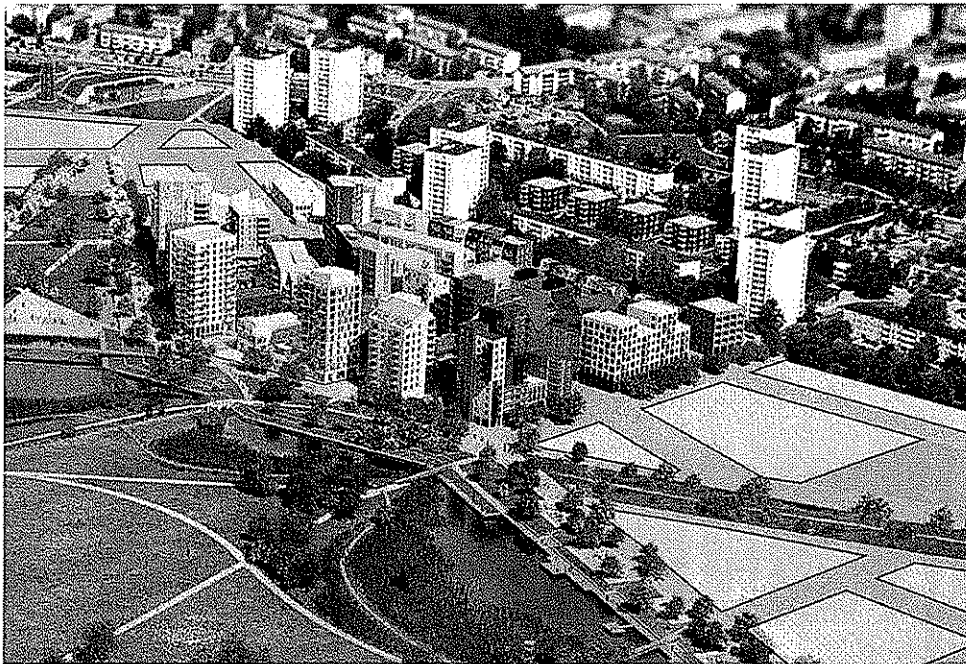
Den föreslagna byggnadsstrukturen tillför en ny stadsbyggnadskaraktär till Stockholm, med en stor blandning av volymer, funktioner och gestaltungsuttryck inom samma kvarter. Illustration: White arkitekter.
