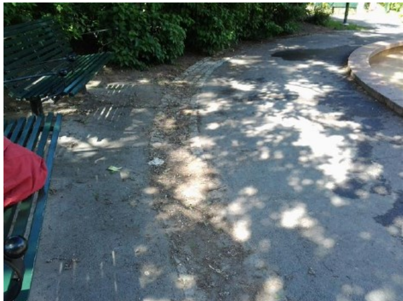
Exempel på bristande städning. Mycket föroreningar från tät vegetation kvar på hårdgjord yta intill plaskdamm.
