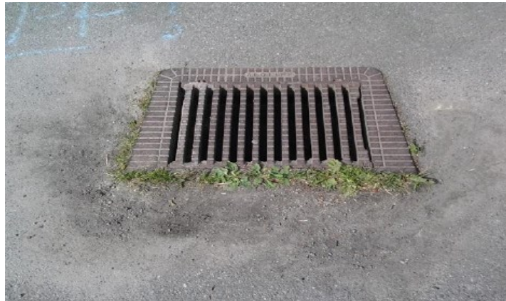
Mycket jord kvar vid dagvattenbrunn intill plaskdamm.
