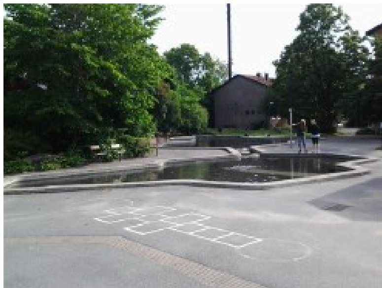
Båtsmanstorpet, Bromma, nivåskillnad i dammen på ca 7 – 8 cm. Ett litet vattenfall vid stenarna i mitten.
