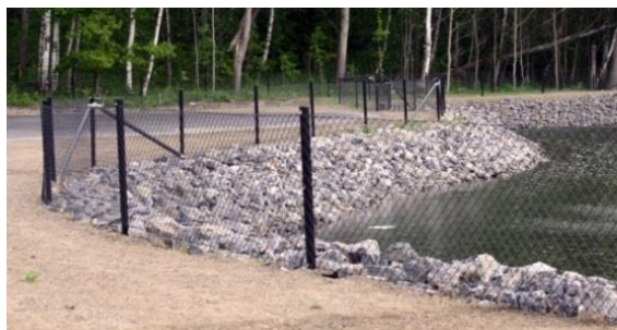
T v: Exempel på staket till skydd mot fallolyckor
