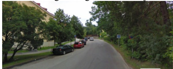
Bild 11. Sörgårdsvägen/Spånga torgväg före ombyggnad
