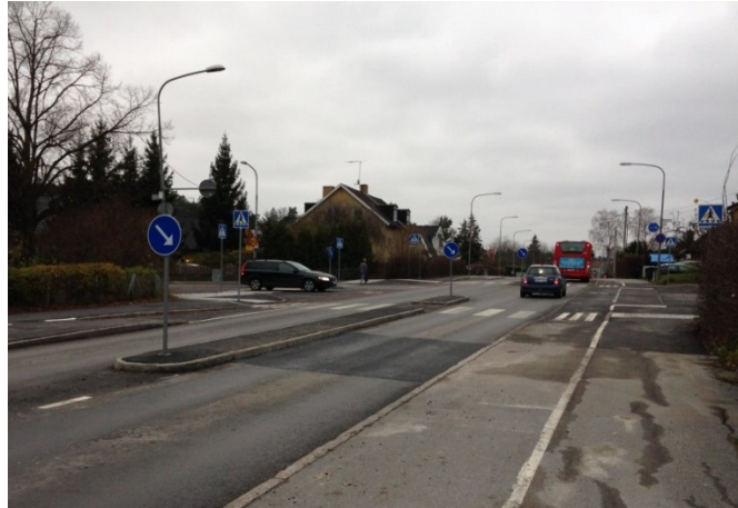
Bild 5. Sörgårdsvägen/Kälvestavägen efter ombyggnad
