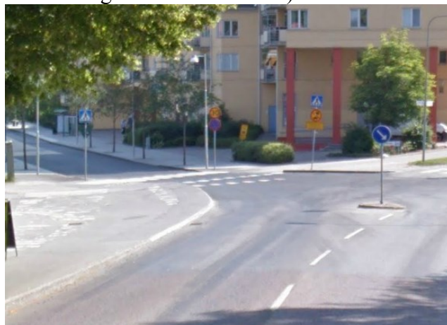
Bild 9. Sörgårdsvägen/Värstagårdsvägen före ombyggnad
