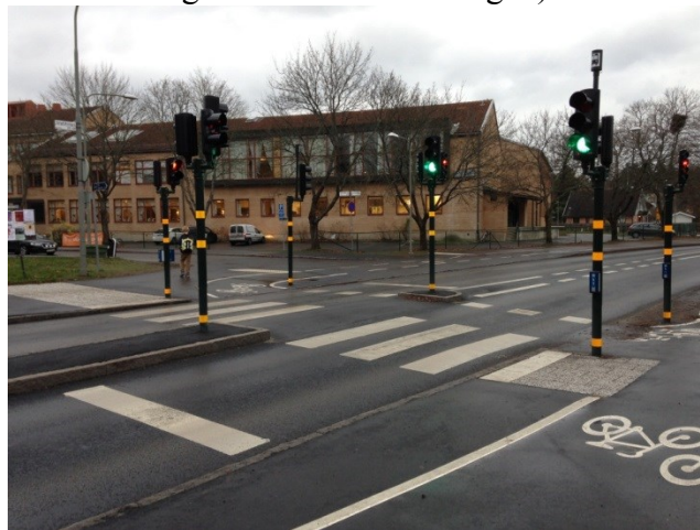
Bild 8. Sörgårdsvägen/Solhemsvägen/Adolf Rudbecks väg efter ombyggnad
