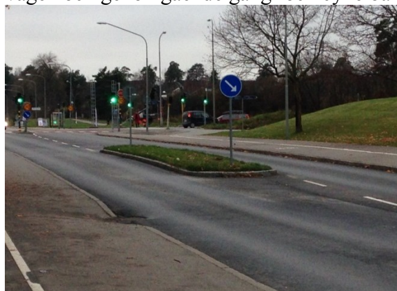
Bild 2. Sörgårdsvägen/Uppgårdsvägen efter ombyggnad
