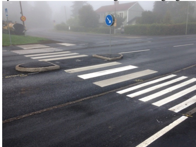
Bild 4. Sörgårdsvägen/Utgårdsvägen efter ombyggnad
