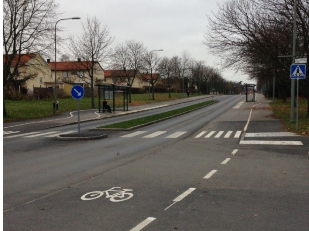
Bild 3. Sörgårdsvägen/Älvkvarnsvägen efter ombyggnad
