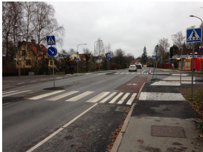
Bild 7. Sörgårdsvägen/Vinstavägen efter ombyggnad
