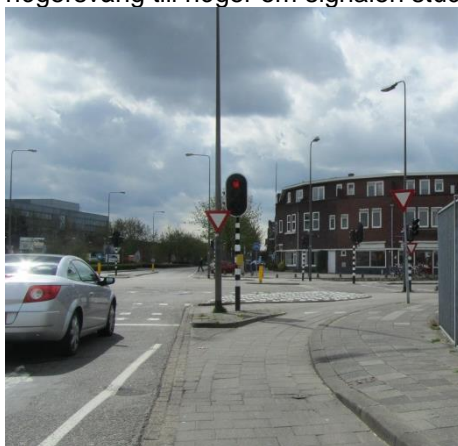
Figur 2 Holländsk högersväng till höger om signalen. Cyklister som ska rakt fram omfattas av signalen vid övergångsstället.
