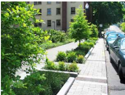
I stråkets mer urbana miljöer kan så kallade "rain gardens" med fördel anläggas för att på ett effektivt sätt samla upp och fördröja vattnet. Här exempel från Portland. Foto: City of Portland, Oregon
