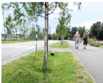
Svackdiken vid Bollmora allé reglerar stora flöden vid häftig nederbörd.
