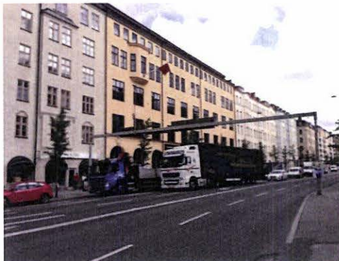
Figur 2. Hornsgatan väster om Ringvägen, vid Hornstull.
