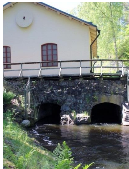
Uddby kraftverk i Tyresåns utlopp uppfördes år 1898.
