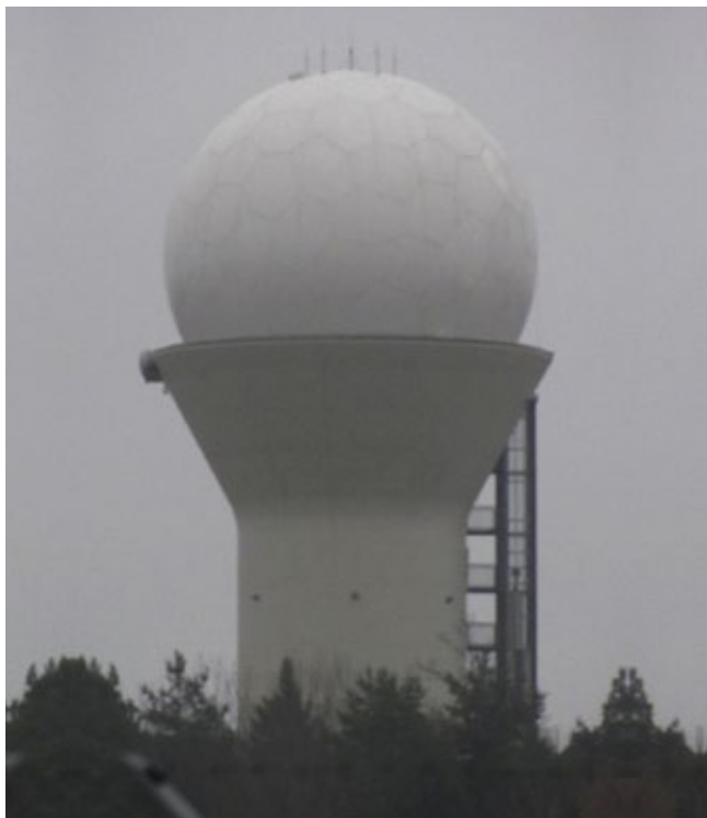
Exempel på en LfV radaranläggning, Bällsta.
