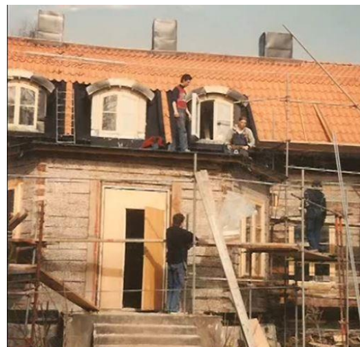
Under renoveringen. Frontespisen har ersatts av takkupor anpassade till byggnadens karaktär och ålder.
