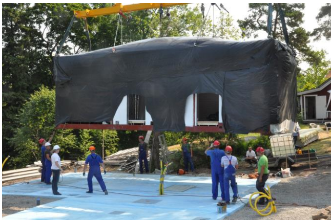
Montage av 1:a modulen, Visningshus på Värmdö, 2013
