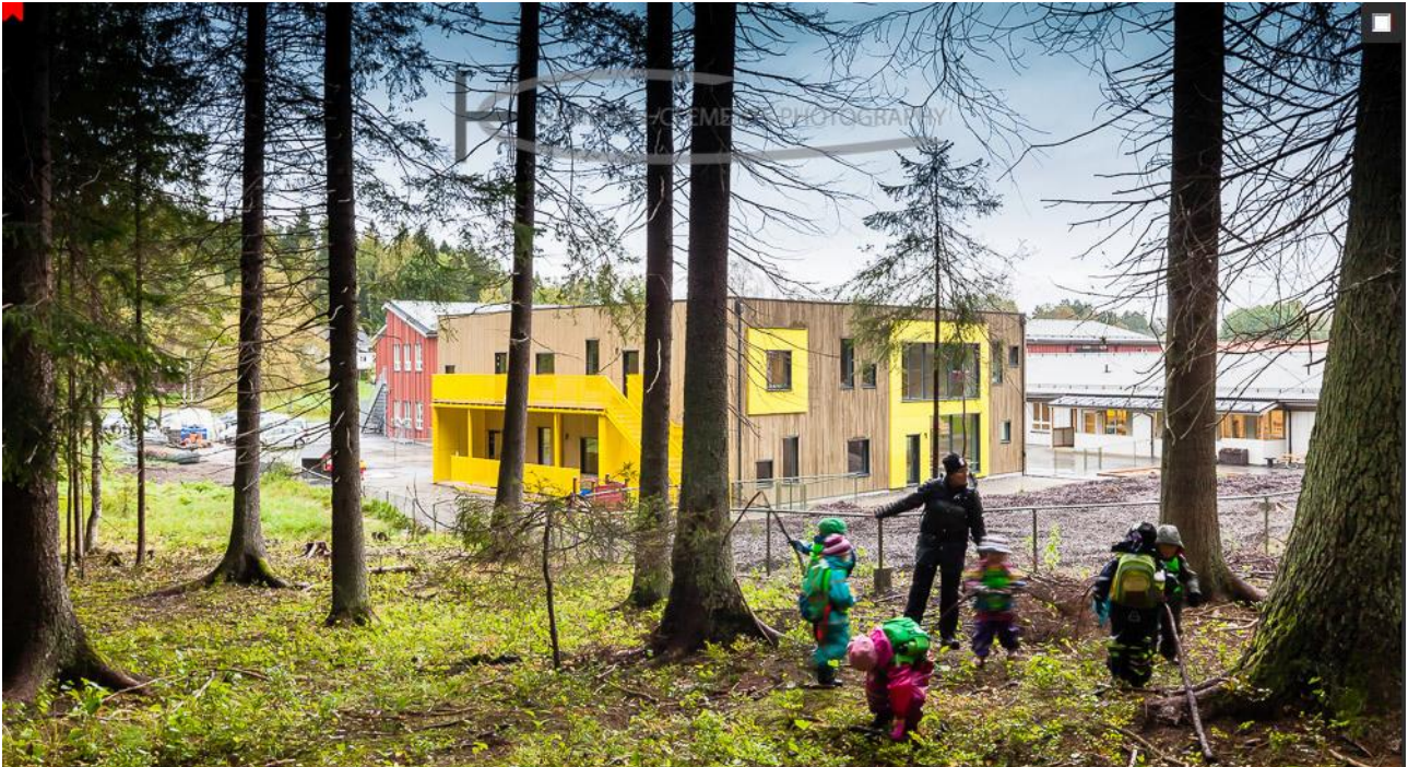
Soverandor under utrymningstrappans balkong. Designen medger ett energisnålt hus, 15kWh/m 2 ,år
