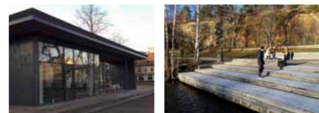
Vattenruimmet tillgängliggörs med spänger och bryggor. En plats för caféyta tillskapas som ett sammanlänkande element mellan den norra aktivitetsparken och det södra naturrummet.
