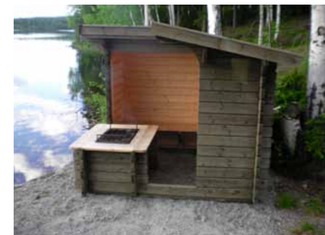
Befintlig glänta kompletteras med ett vindskydd i trä med en grillplats samt eventuellt bänkbord.
