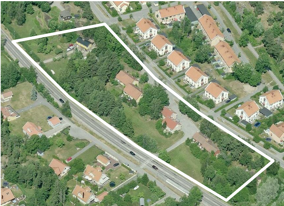
Flygbild över området sett från söder. Tyresövägen löper i förgrunden och Maria Sofias väg parallellt med denna längre norrut. Planområdet är markerat med vit linje.
