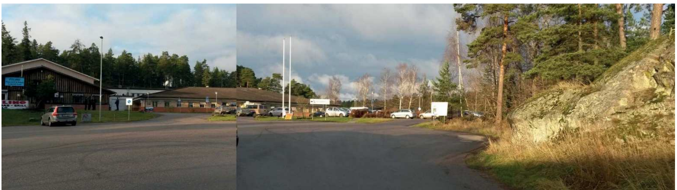
Fastigheten idag med kontors- och lagerlokaler.
