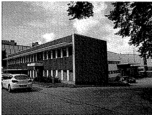
Fotografi från Virkesvägen över befintlig byggnad på Påsen 8.
