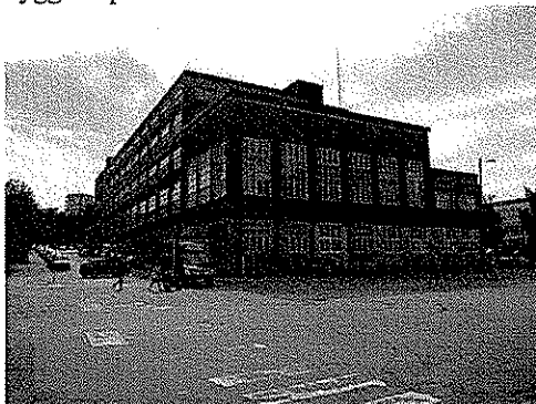
Fotografi över Heliostorget mot den byggnad inom Påsen 10 vars ursprungliga del ska bevaras (byggnad närmast Heliosgatan).
