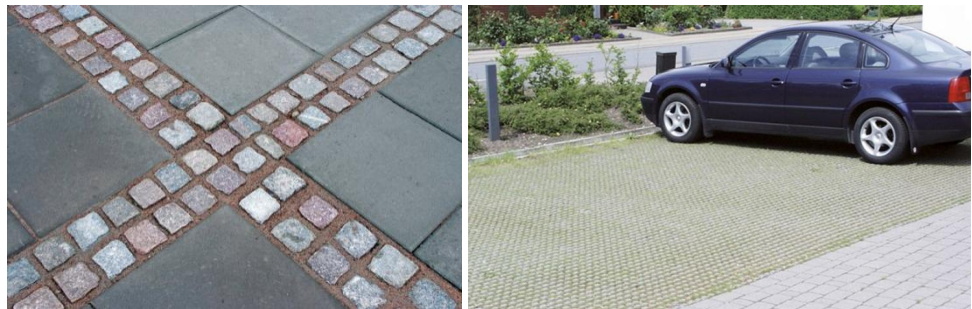
Figur 19. Gles plattsättning med sandfog och gräsarmering är två ytbeläggningar som minskar avrinningen.
