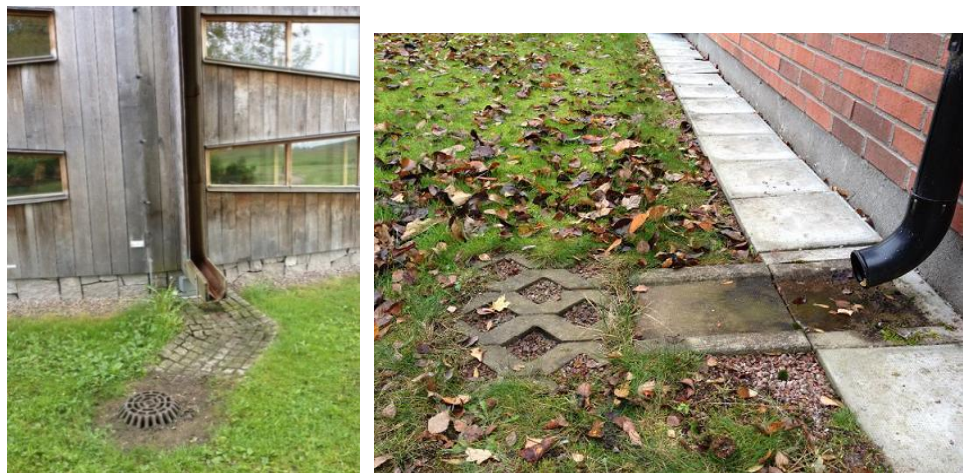
Figur 14. Utkastare till dagvattenbrunn respektive infiltration.
