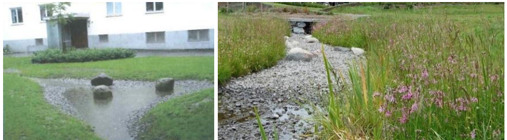
Figur 21. Öppet avvattningsstråk/översvämningssyta. (bild från Svenskt vatten P105 och VegTech)
