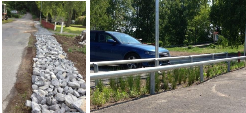
Figur 20. Krossmaterial/ grönyta som kan läggas vid parkeringsytor.
