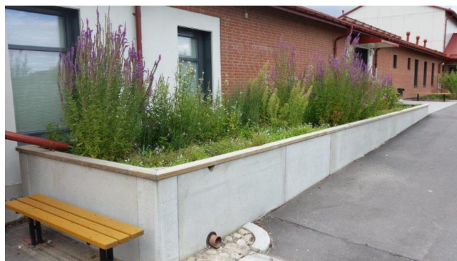
Figur 16. Exempel på upphöjt biofilter och raingarden.
