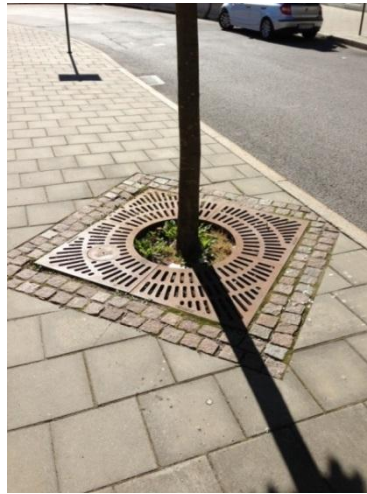
Figur 18. Träd som planterats i skelettjord dit dagvatten kan ledas och infiltrera. T.h. Principskiss på utformning av trädgropar i stadsmiljö, idé från Malmö stads tekniska handbok, (Teknisk handbok, Malmö stad, 2015)
