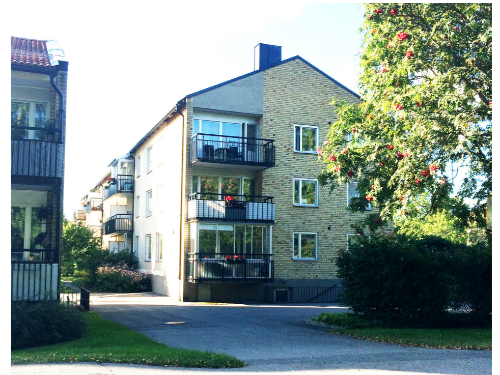
Befintlig 50-talsbebyggelse i anslutning till parkens norra del, 3 våningar
