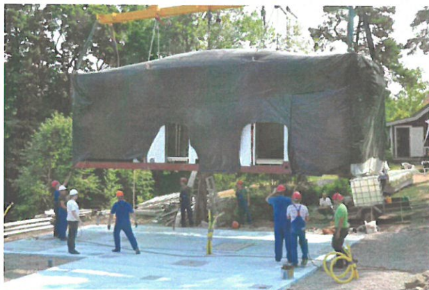
Montage av 1:a modulen, Visningshus på Värmdö, 2013
