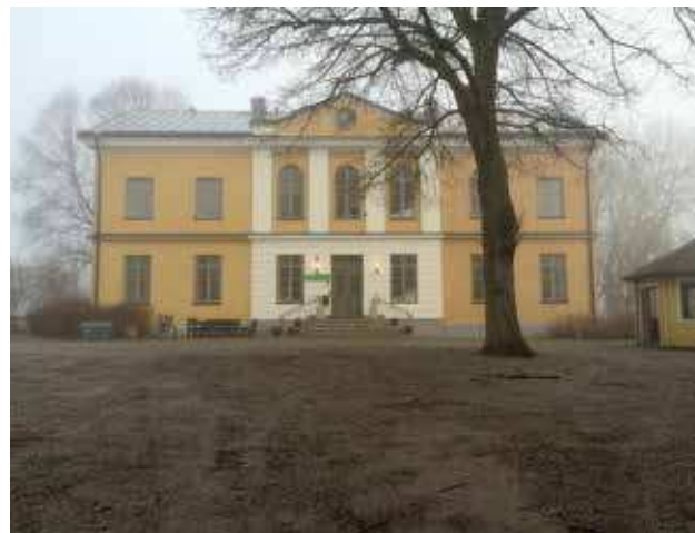
Skarpnäcks gårds huvudbyggnad, uppförd 1865-67
