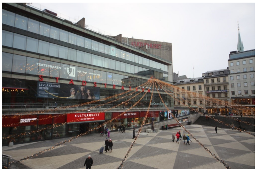
Kulturhuset norrfasad med huvudentré mot Sergels torg.
