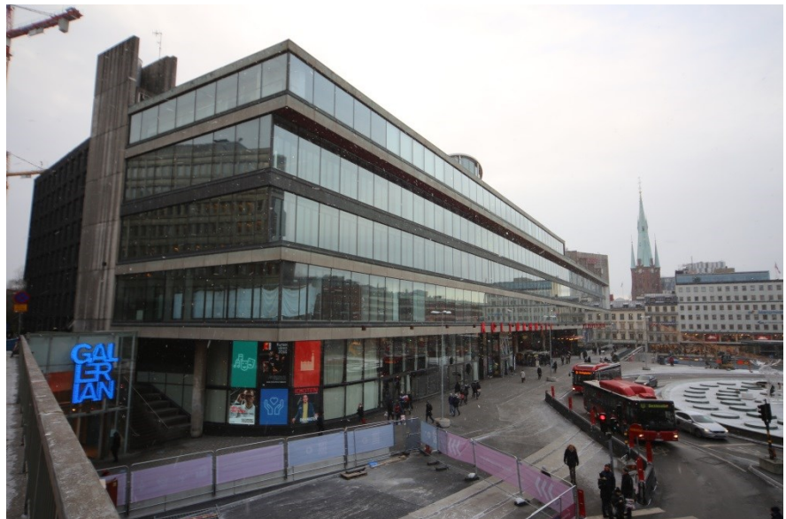
Kulturhusets östra och norra fasad mot Sergels torg sett från Malmskillnadsgatan.
