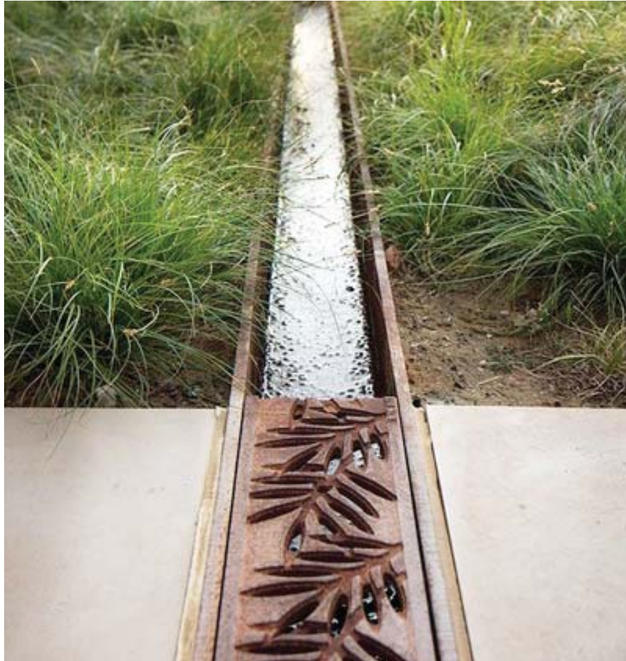
Öppen ränna leder vattnet till planteringar och fördröjningsmagasin.
