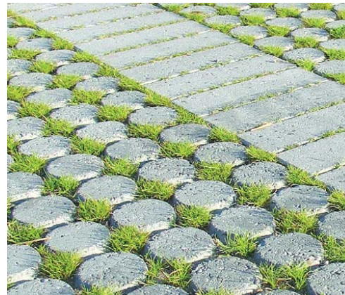
Armerat gräs som infiltrationsyta.
