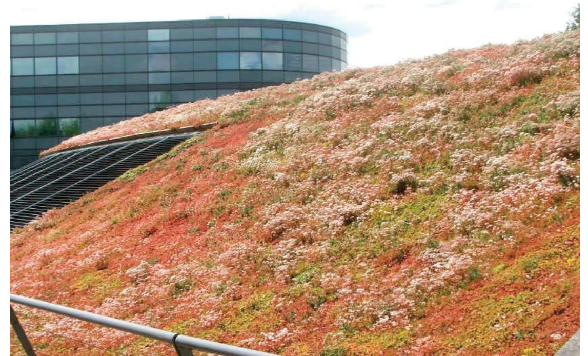
Sedumtak som infiltrationsyta.
