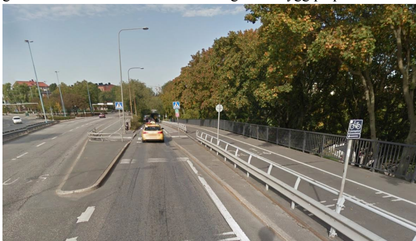
Figur 2. Vy över det södra övergångsstället söderifrån. Övergångsstället saknar hastighetssäkring
