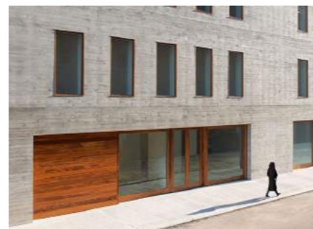
STORA HÅLTAGNINGAR I STENSOCKEL
