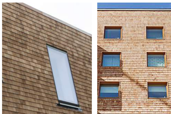
EXEMPEL PÅ FASADER AV CEDERSPÅN MED PLÅTAVTÄCKNING AV TAKFOT.
