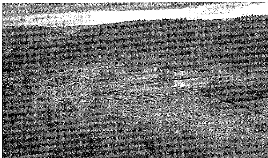
Flemingsbergsvikens våtmarksanläggning nordväst om Orlången.
