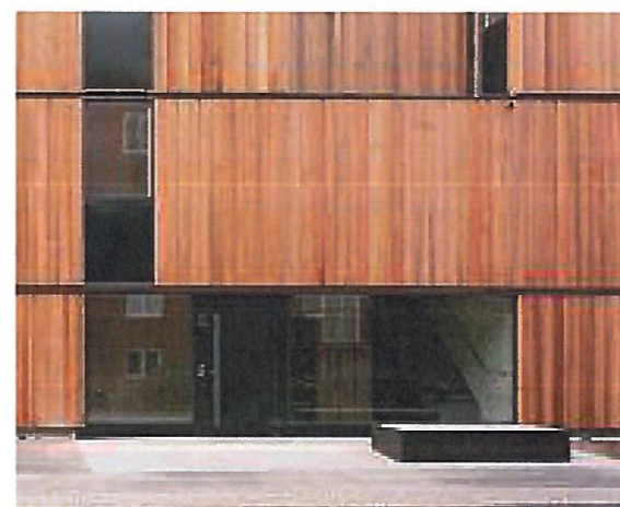
ENTRÉ UTAN SKÄRMTAK, SKAGERSKA HUSET, ÅRSTA, OWC ARKITEKTER
