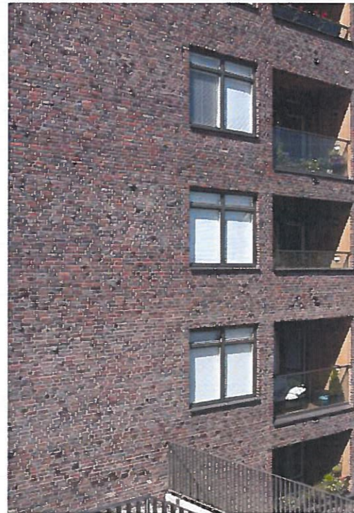
10. TEGELRÄCKEN VID INDRAGNA BALKONGER RACKARBERGEN, JOLIARK
