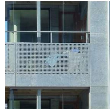
ALT. GENOMSIKTLIGT BALKONGRÄCKE MED PERFORERING I TVÅ TÄTHETER
