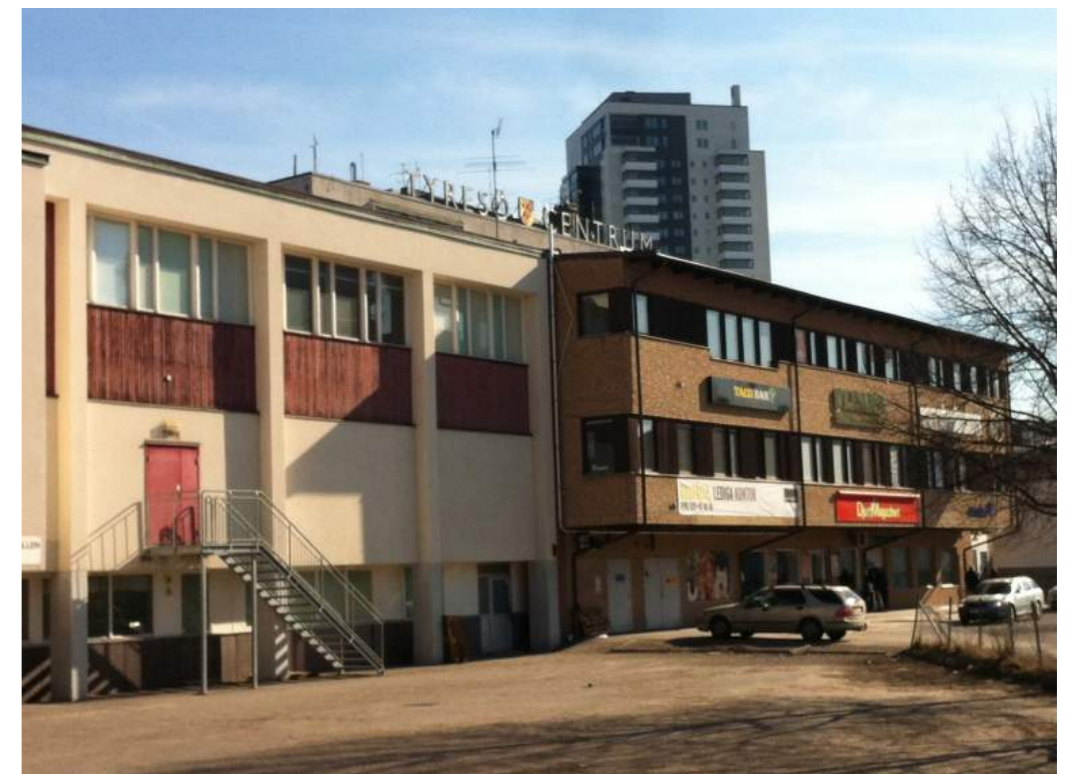
BOLLMORAHALLEN MED INTILLIGGANDE GRANNFASTIGHET
