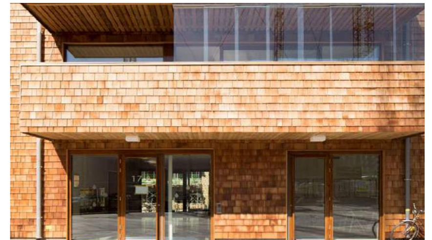
BALKONGER SOM FUNGERAR SOM SKÄRMTAK ÖVER ENTRÉER, STRANDPARKEN, SUNDBYBERG, WINGÅRDHS ARKITEKTER
