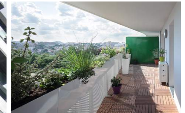
BALKONGLÅDA INTEGRERAD I RÄCKE
