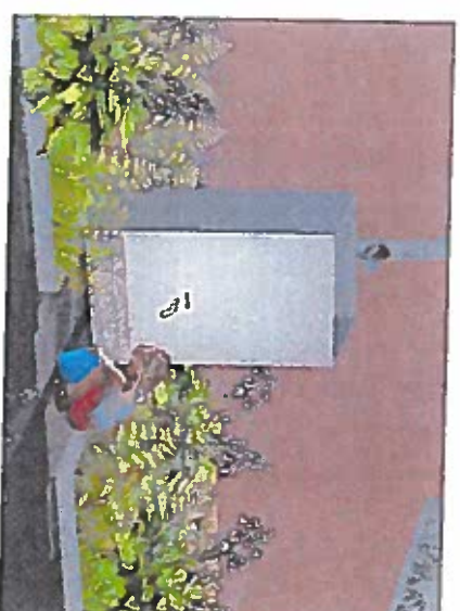
14. REGNSKÖRDARTUNNA ANPASSADE FÖR FLERFAMILJSBOSTÄDER. DET BRÄDDADE TAKVATTNET FÖRDROJS OCH GÖRS TILLGÅNGLIGT FÖR PLASKLICKAR OCH BEVATTNING. STUPRÄNNAN SOM Fyller TUNNAN MED REGNVATTEN KAN STALLAS OM SÅ ATT TAKVATTNET VID KALLARE TIDER, DÅ TUNNAN SKA VARA TÖMD, LEDES BORT.
