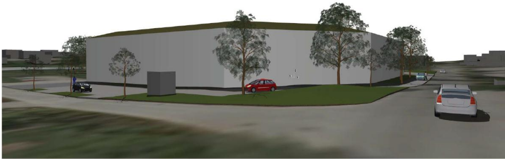
Bilden ovan: Vy mot söder (bebyggelsen mot norr). Den föreslagna bebyggelsen från korsningen Fornuddsvägen/ Ängsvägen. Befintlig transformatorstation. Illustration: FRAM arkitekter
