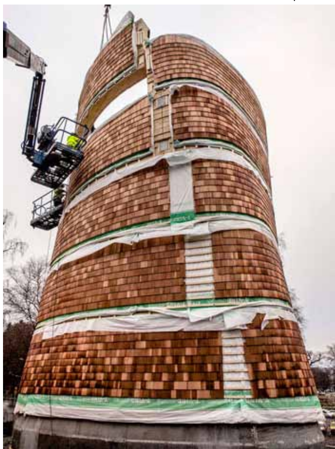
Ett avluftstorn till Norra länken – utförs i trä i Nationalstadsparken
